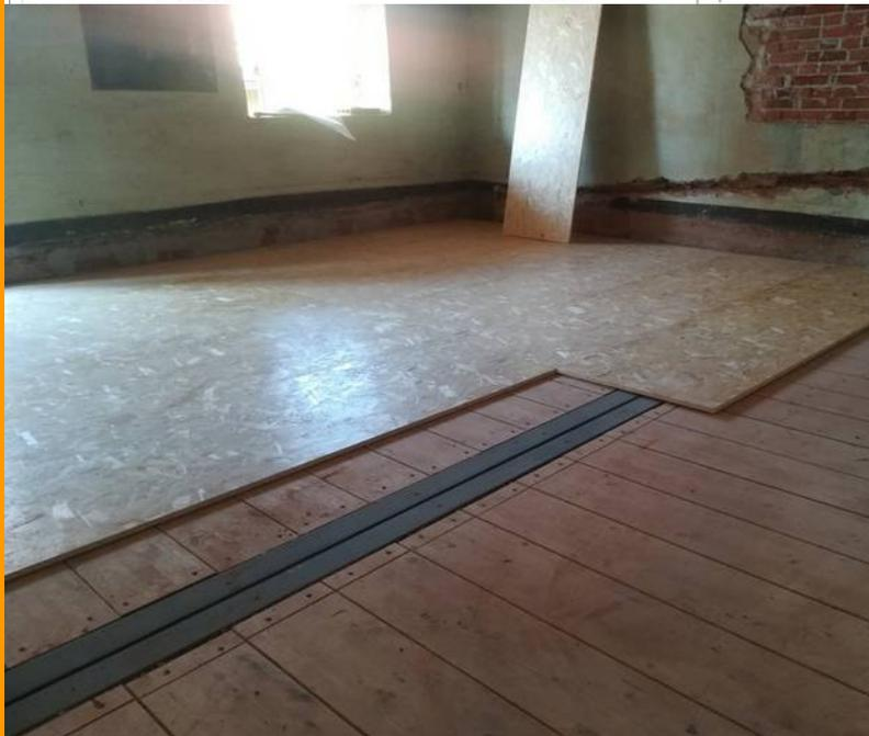
DETT. 01 - FISSAGGIO SOLAIO IN LEGNO A MURATURA PORTANTE
