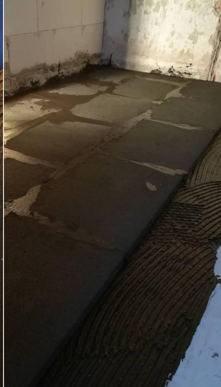
posa lastre foamglas **T4+/40** con collante Foamglas **PC56** nella misura di kg/mq 4,5-5,0 ca.
